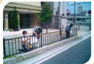
プレートの取り付け
