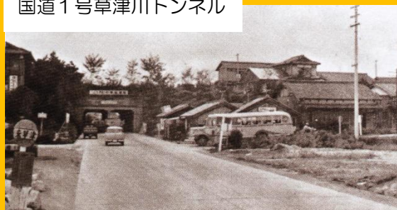
国道 1 号草津川トンネル
