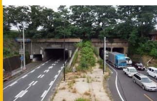
解体前のトンネル
