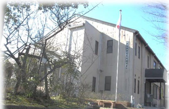
昭和61年3月建築 / 平成21年度EV設置
